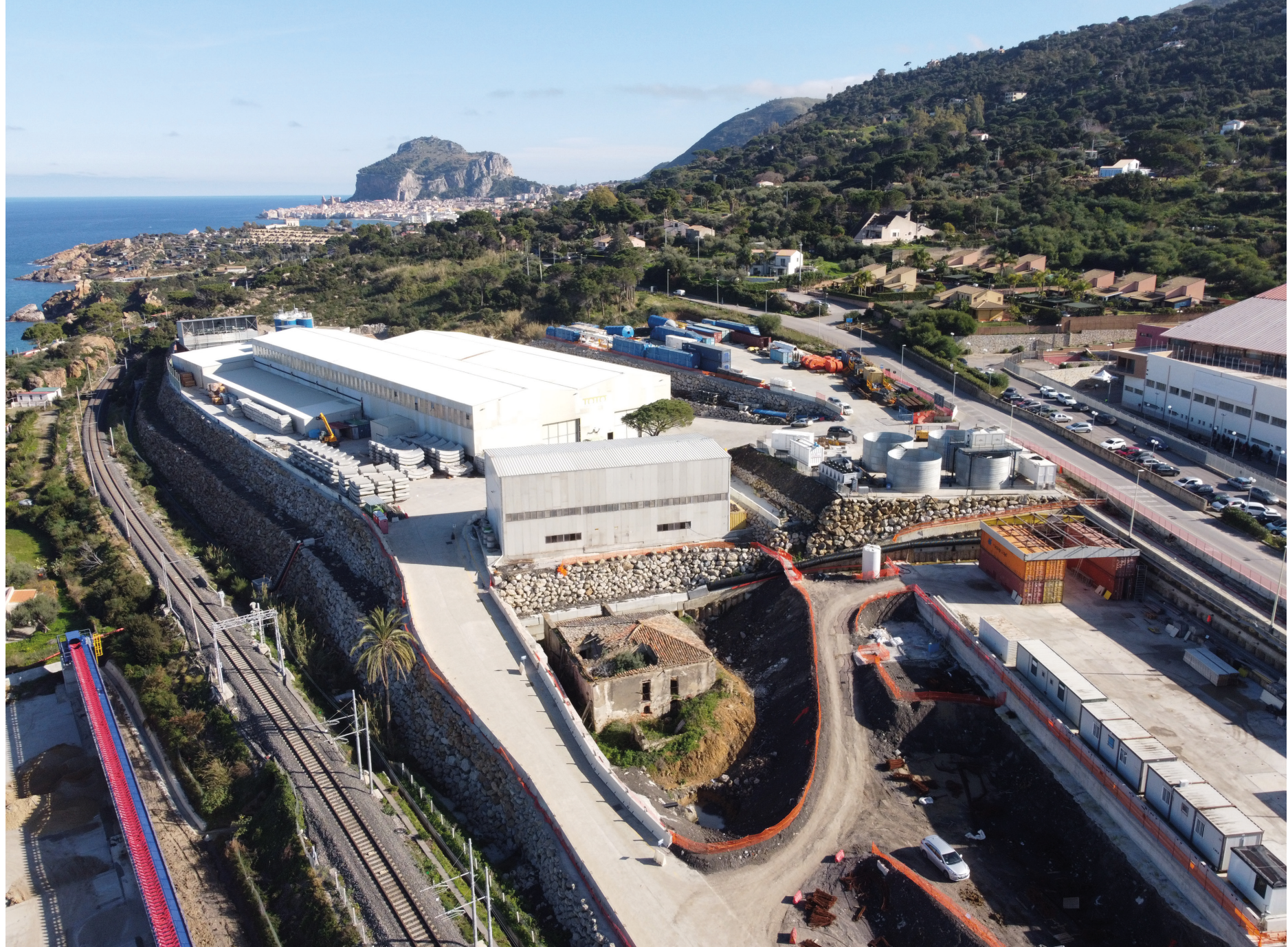
Cantiere Toto Costruzioni Generali Ogliastrillo – Cefalù
